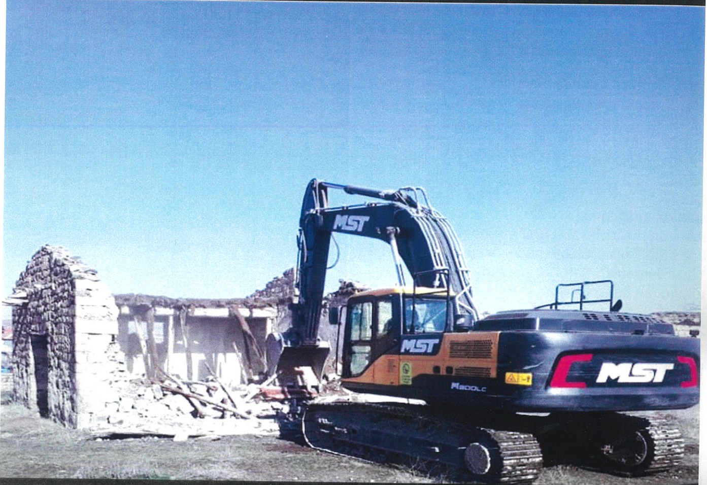
ALT YAPI MALZEME SERİMİ, YOL İYİLEŞTİRME VE TOPRAKLAMA ÇALIŞMALARI
